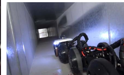
ダクト内移動の実証実験
