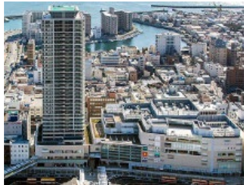
▲ 写真 当該事業により建設されたマンション及び施設
