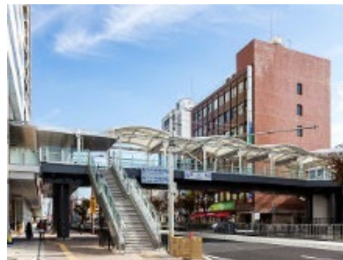
▲ 写真 交通量が多い国道2号をまたぐ立体横断歩道
