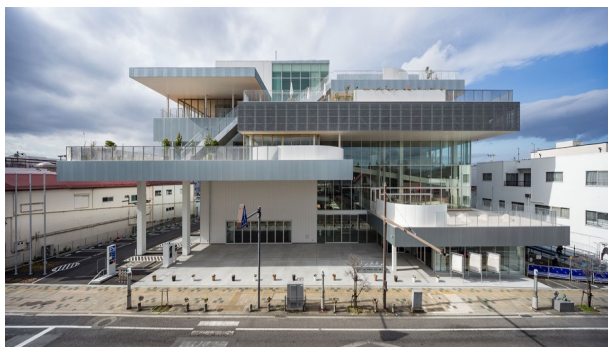
▲完成した市民交流センター
