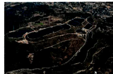
【米倉山太陽光発電所】
