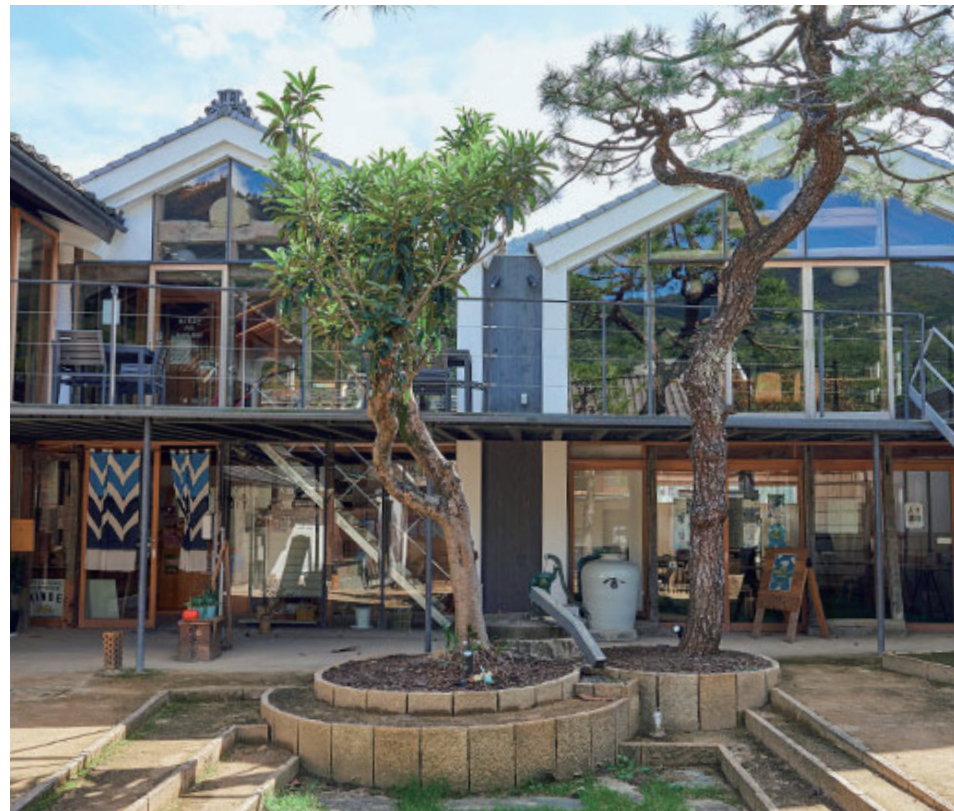
徳島県三好市地域交流拠点施設「真鍋屋」築100年以上の旧真鍋家の商家
