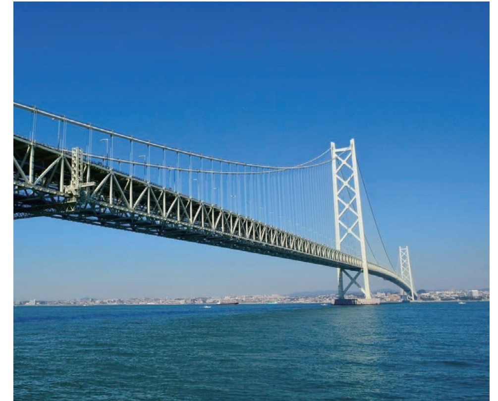
神戸と淡路島を繋ぐ世界最長の吊橋—明石海峡大橋—
