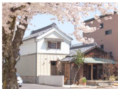
▲蔵カフェ&コミュニティスペース [愛知県豊田市] ※10 (豊田まちづくり㈱により、商店街の中で長年空き家となっていた築100年の蔵と古民家を子育て世代のコミュニティ施設MAMATOCO(ママトコ)として再生)
