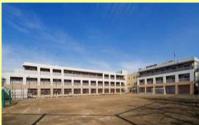
学校を改修して整備した事例
