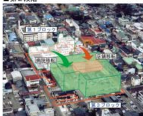
第3ブロック竣工・第1ブロックから移転 第1ブロックで解体・建設工事
