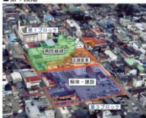
第1ブロックにて営業の継続 第3ブロックで解体・建設工事
