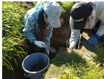
＜鳥取県鳥取市（R元モデル事業）＞ 地方の農業に関心のある都市部からの 滞在者との協働による農業用水路の修繕
