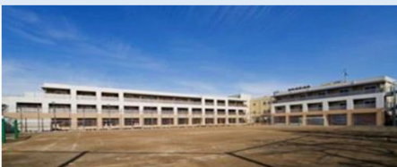
学校を改修して整備した事例
