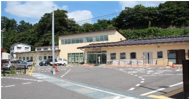
完成した多世代交流施設「メーラプラザ」
