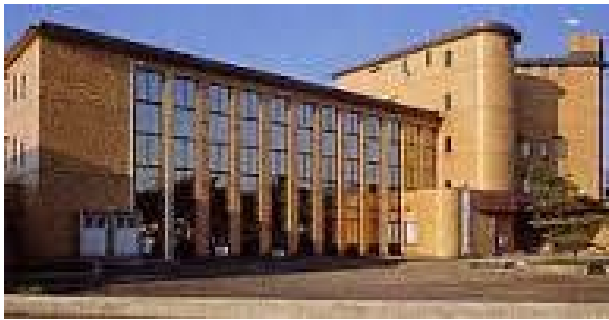
北上市役所 和賀庁舎 JR北上線「横川目駅」から約0.8km (「北上駅」-「横川目駅」所要時間18分)
