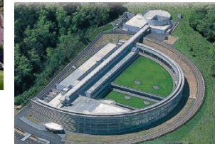
若狭湾エネルギー研究センター (福井県敦賀市)
