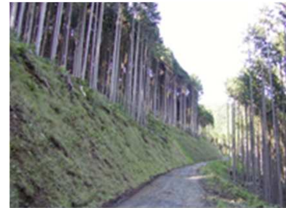
県営林道施工例
