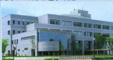
「香川インテリジェントパーク内 香川県産業頭脳化センタービル」
