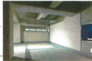
消火救助訓練室 ・木材や油の炎を用いて行う消火訓練可能
