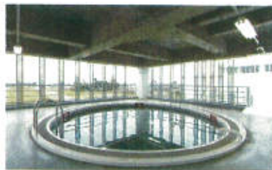
水難救助訓練施設 ・潜水プール（水深 10m）水深可動型 ・気泡発生装置による溺水訓練対応
