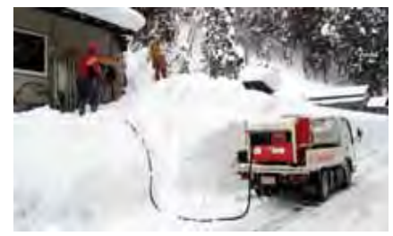
【ホームタンクへの給油の様子】
