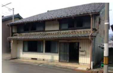
【集落内の空き家】
