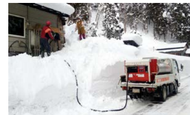
【ホームタンクへの給油の様子】
