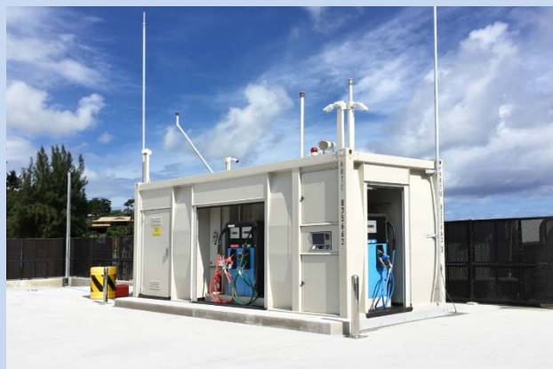
過疎地でのコンテナ式給油所(地上タンク)の活用に向けた実証実験
