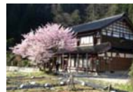
古民家等の改修
