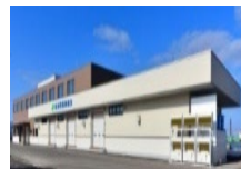
集出荷・貯蔵・加工施設の整備
