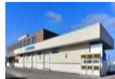
集出荷・貯蔵・加工施設の整備
