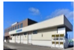
集出荷・貯蔵・加工施設の整備
