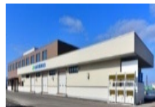
集出荷・貯蔵・加工施設の整備
