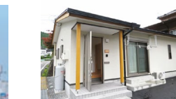
空き家の改修（お試し居住施設）
