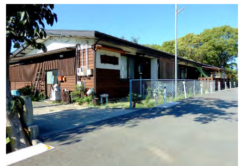
築 50 年の保育所を改修
