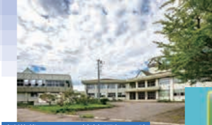
新世代モーター特性評価ラボ 外観(廃校利用)
