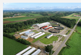
鹿追町環境保全センター 出所：鹿追町
