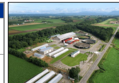
鹿追町 バイオガスプラント
