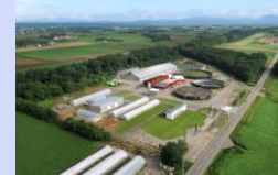
鹿追町環境保全センター 出所：鹿追町
