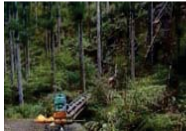
【モノレールの設置実証】
