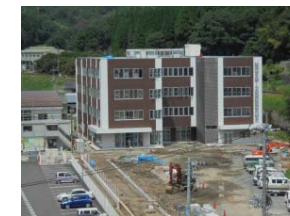
図6 専門学校建設の現況写真 (平成29年8月)
