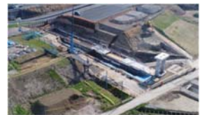
排水樋管改築
