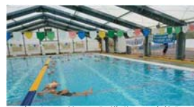
バイオマス熱利用設備導入予定施設 (北条B&G海洋センタープール)
