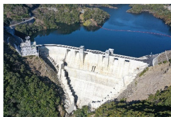
完成後の状況
