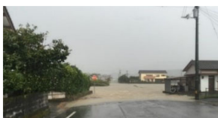
H28の浸水状況
