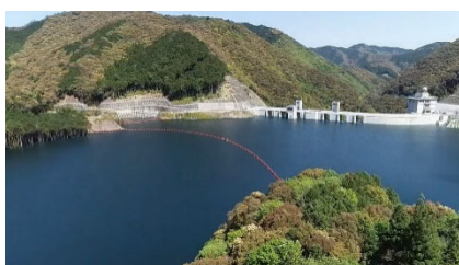
R2.4.21 試験湛水最高水位に到達
