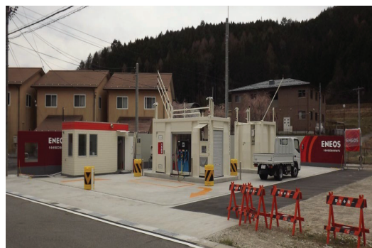
地上型タンクを設地したGS/コモタ株式会社
