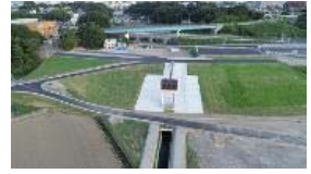
排水樋管改築
