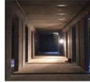
地下式調整池
