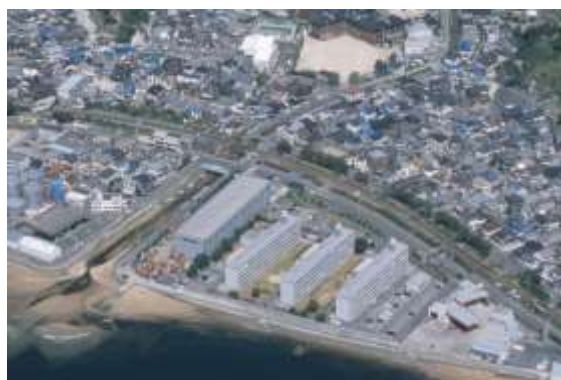
写真－2 子育て支援住宅として改修した住宅
