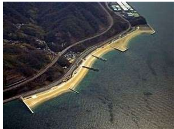
写真-4 ベイサイドビーチ坂 (JR水尻駅付近)
