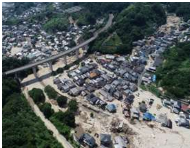
写真－1 壊滅的被害を受けた坂町小屋浦地区
