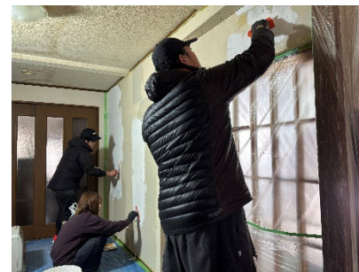
空家改修イベント（漆喰塗り）
