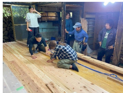
空家改修イベント（床張り）
