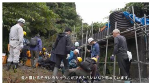
簡易魚道の設置工事の様子
