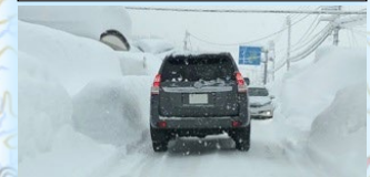
拡幅・運搬除排雪で幅員確保
