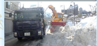
拡幅・運搬除排雪で幅員確保
