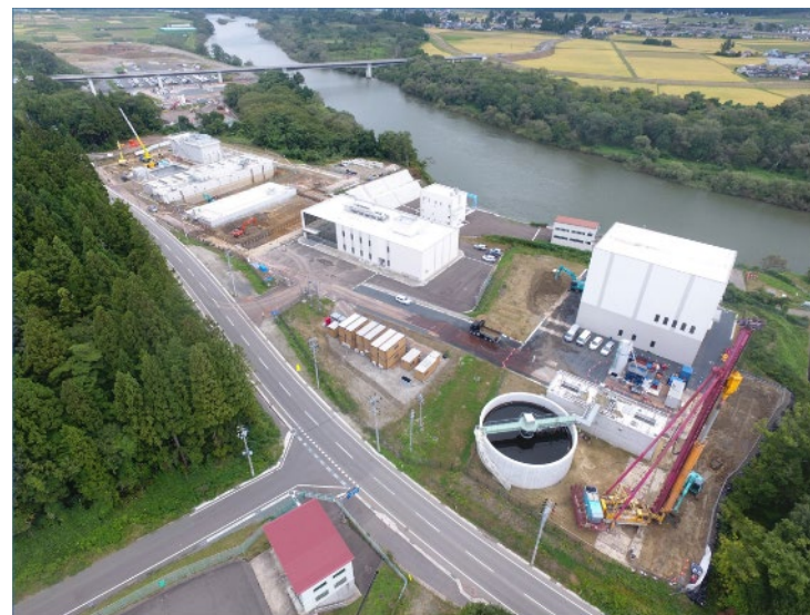
新北上浄水場の全景
