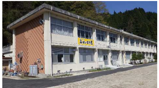
廃校となった中学校を活用した6次産業化拠点施設
