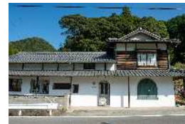
古民家を改修した交流拠点「クロモリ」（河之内エリア）
