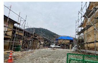
第二期事業 町屋・古民家改修工事現場
