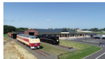
道の駅あびら D51ステーション
