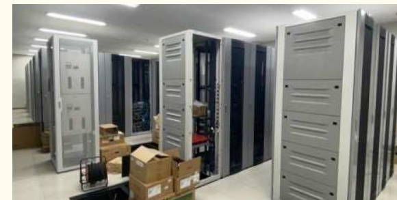
NW機器、サーバ搭載ラック
