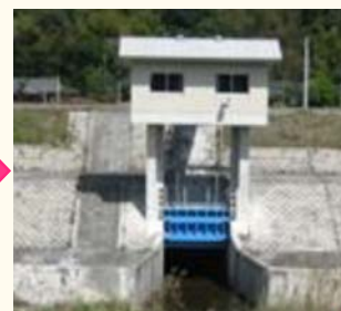
堤防整備、排水機能の強化に 併せて樋門を1箇所に集約
