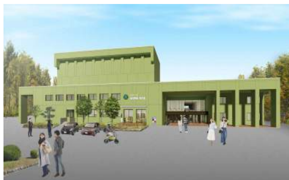
改修後外観イメージ
