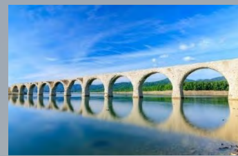
タウシュベツ川橋梁
