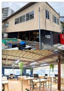
布団屋空き倉庫をリノベしたコワーキング
