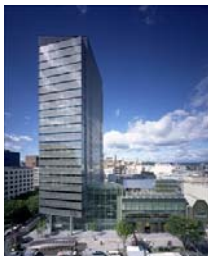
仙台市「仙台ファーストタワー」 (国土交通省土地総合情報ライブラリー「不動産証券化事例」より)
