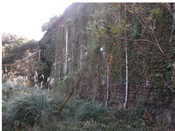
△ 第一病棟 (海軍病院時代から存置)
